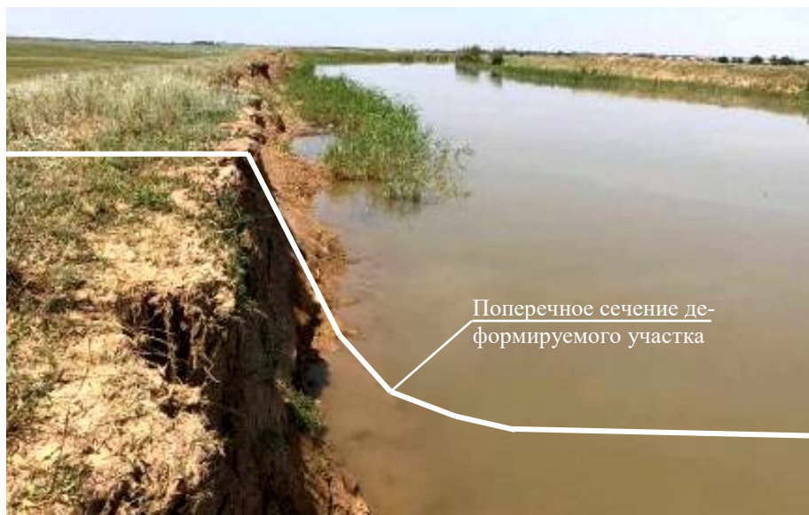
Рисунок 6.13 – Деформация откосов Пролетарского канала на ПК 1630–1640
