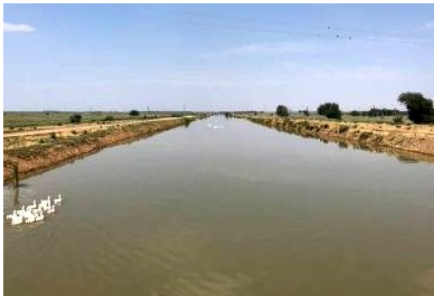
Рисунок 6.2 – Обследуемый участок Пролетарского канала
