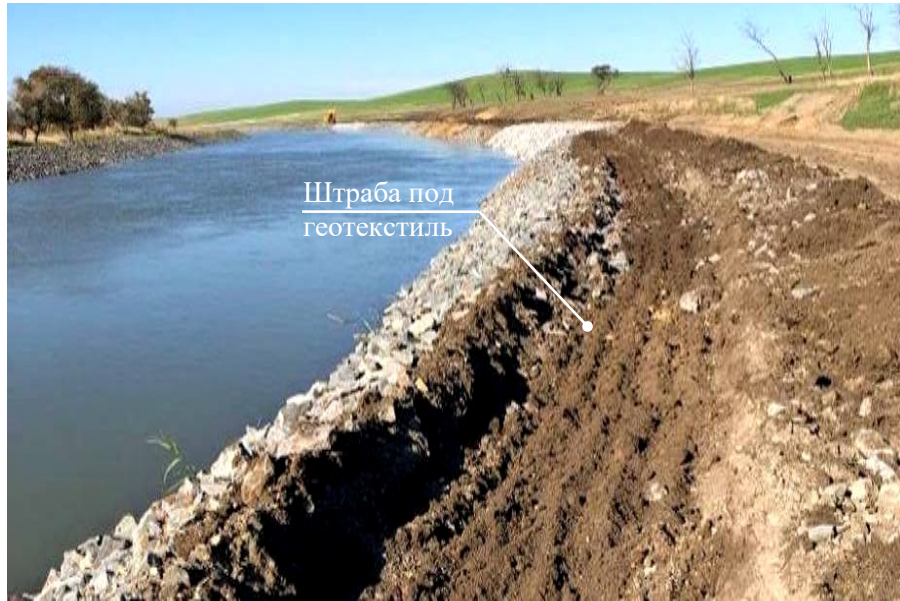
Рисунок 6.23 – Устройство штрабы под геотекстильное покрытие
