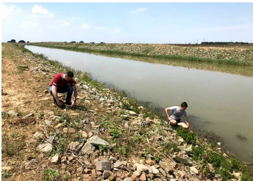
Рисунок 6.16 – Реконструируемый участок облицовки канала
