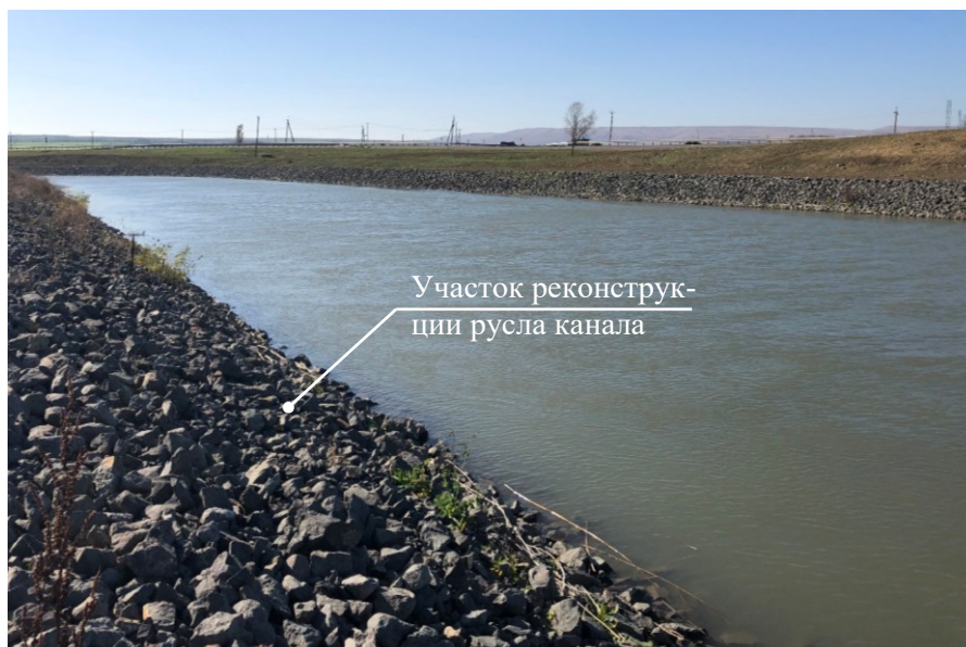
Рисунок 6.20 – Укрепленное камнем ложе Невинномысского канала на ПК 426
