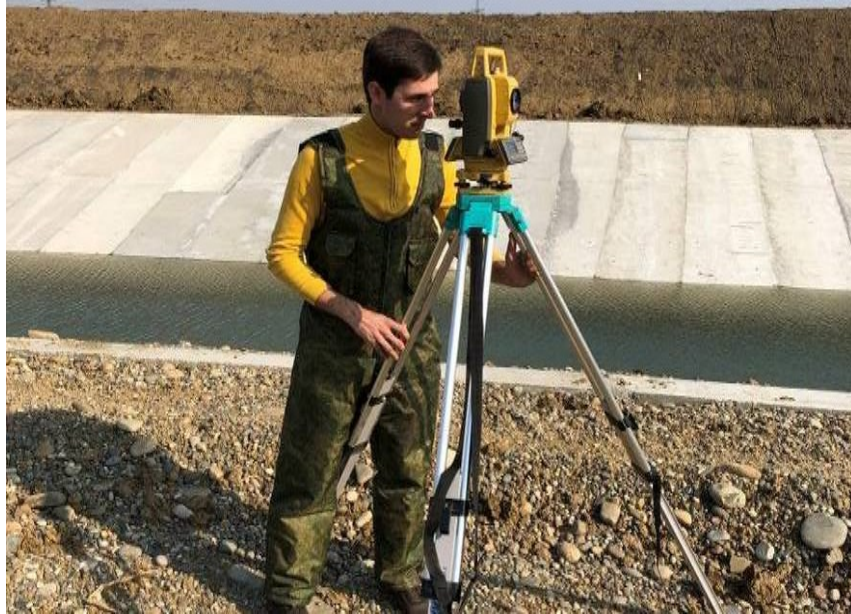
Рисунок 6.24 – Исследования трассы участка облицованного канала
