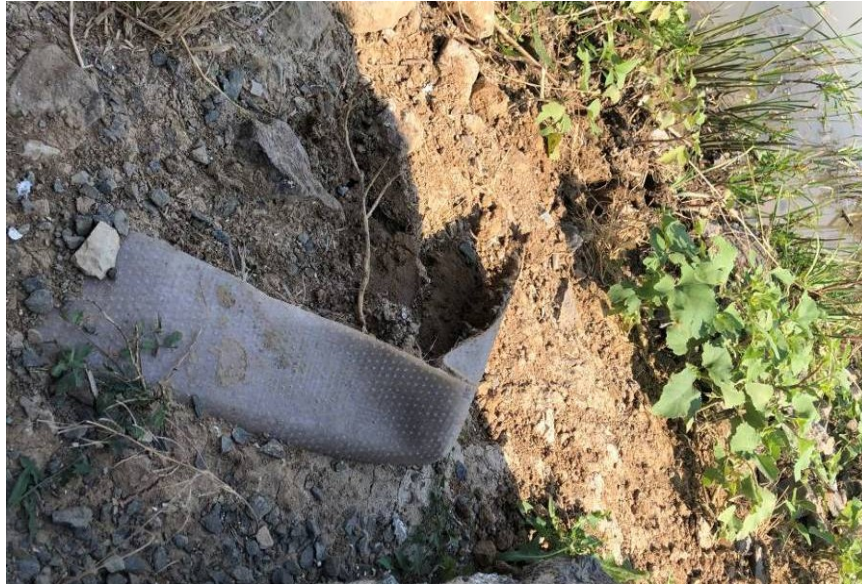
Рисунок 6.18 – Противофильтрационный элемент на откосе канала
