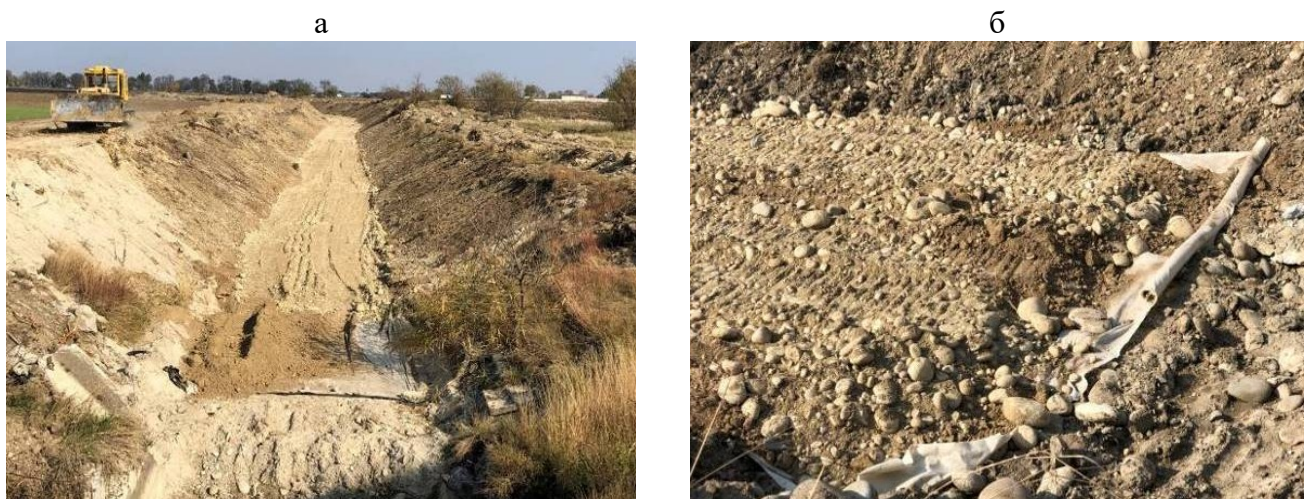
Рисунок 6.32 – Реконструкция участков магистрального канала Аксыра с применением противодиффузионных покрытий:
