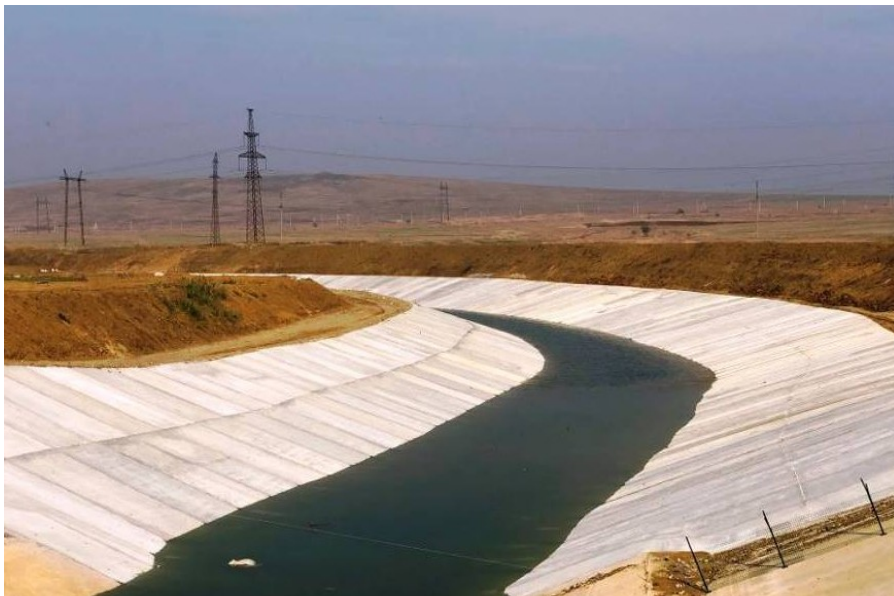
Рисунок 6.4 – Облицованный участок Перебросного магистрального канала
