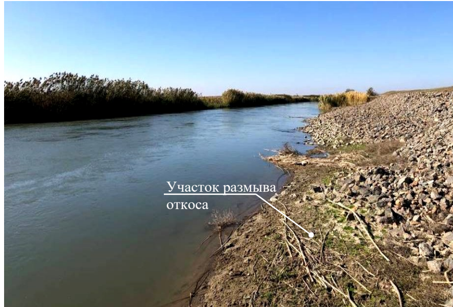
Рисунок 6.19 – Закрепленные участки с размывами и деформациями русла
