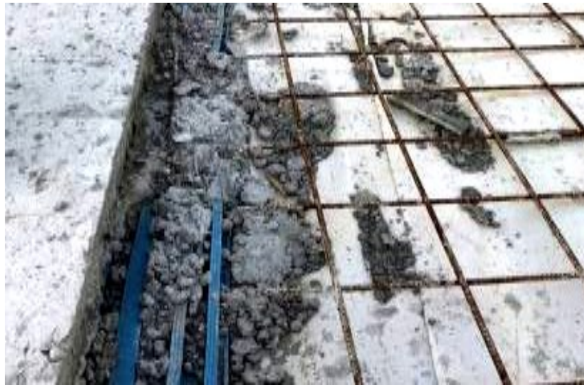
Рисунок 6.27 – Устройство шпоночного соединения на ПФП
