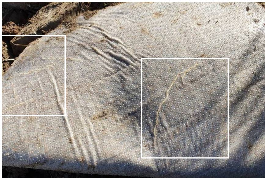
Рисунок 6.10 – Бентонитовый мат с корнями камыша между двумя противофильтрационными слоями
