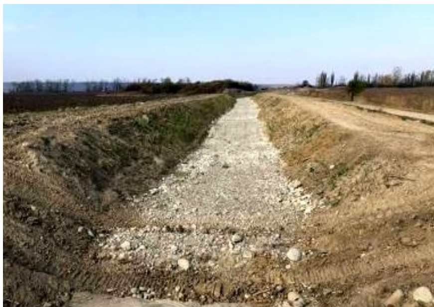
Рисунок 6.5 – Обследуемый участок реконструкции канала Аксыра с противофильтрационным экраном по дну
