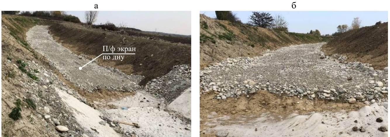
Рисунок 6.30 – Участок реконструкции канала Аксыра: а – сопряжение земляного русла с бетонным покрытием канала; б – противофильтрационный экран по дну, включающий геотекстиль, глину, камень
